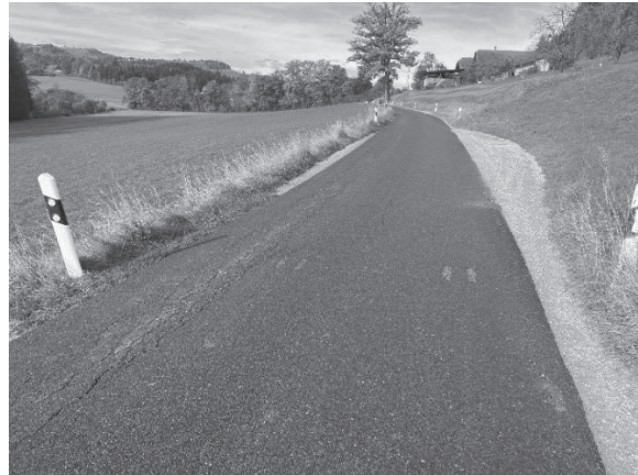
abgedrückter Strassenkörper
