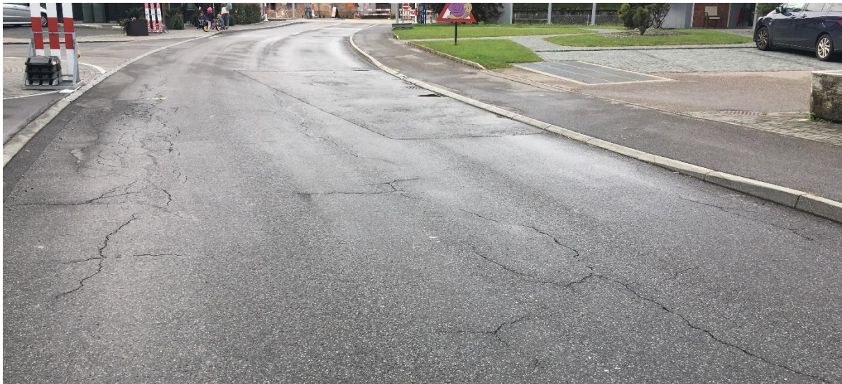
Strassenkörper Einfahrt Sonnhaldenstrasse
