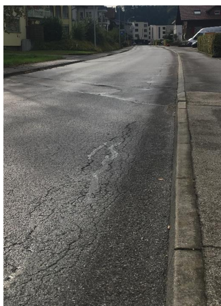
Strassenkörper Höhe Unterdorfstrasse 20
